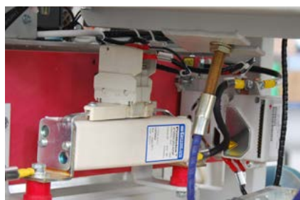
▲ Установка пристрою тестування лінії
