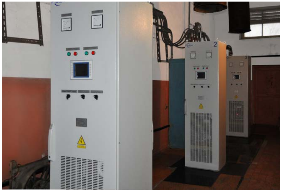
▲ Випрямляючі агрегати після модернізації
