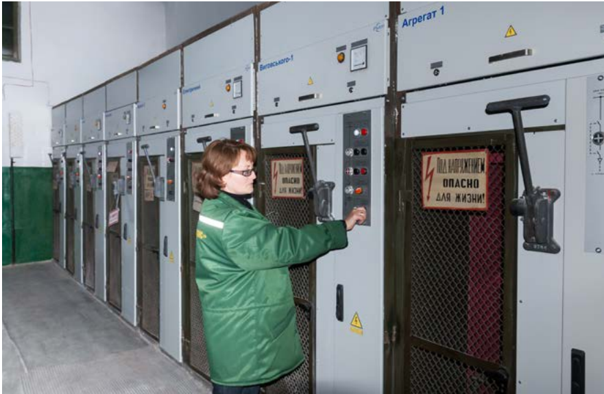
▲ Розподільчі пристрої +600 V після модернізації
