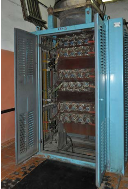
▲ Випрямляючі агрегати до модернізації
