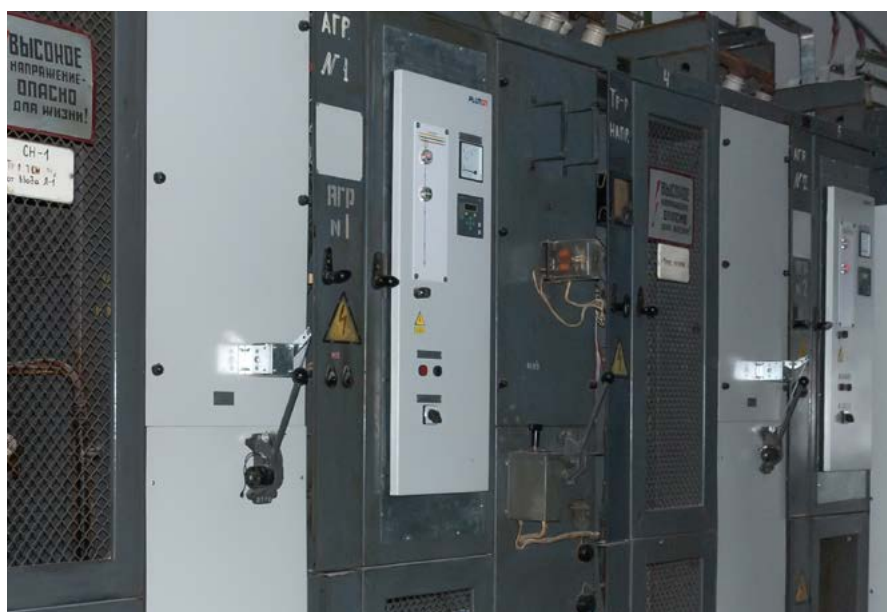
▲ Модернізація розподільчих пристроїв 6 (10) kV
