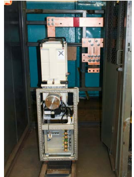
▲ Заміна швидкодіючого вимикача
