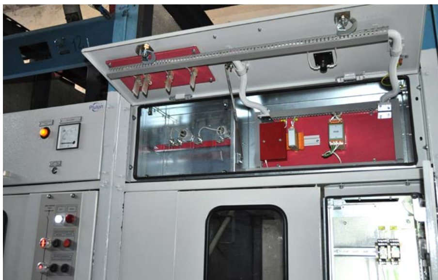
▲ Відсік високої напруги після модернізації розподільчого пристрою +600 V
