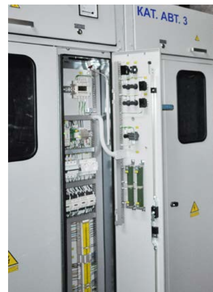
▲ Відсік керування після модернізації розподільчого пристрою +600 V
