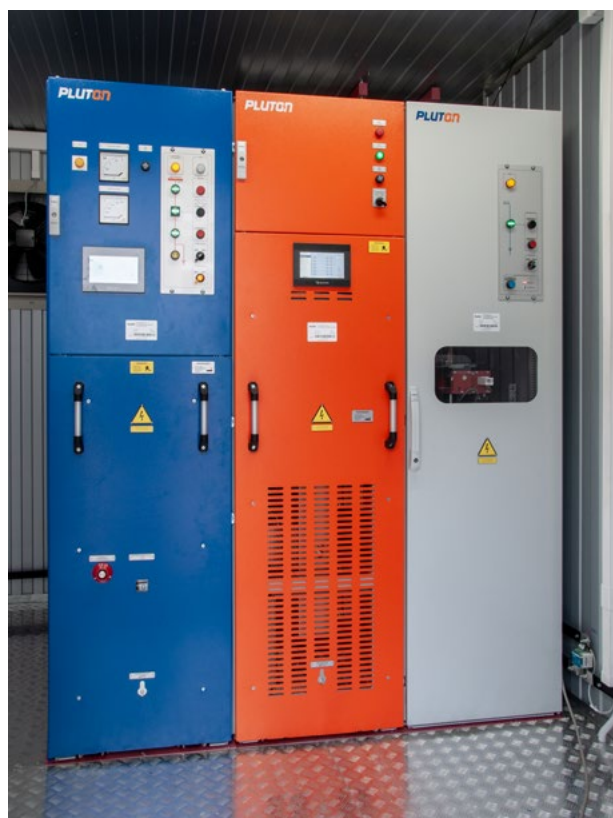
▲ РП негативної шини (справа), випрямляч (у центрі) РП постійного струму (зліва)
