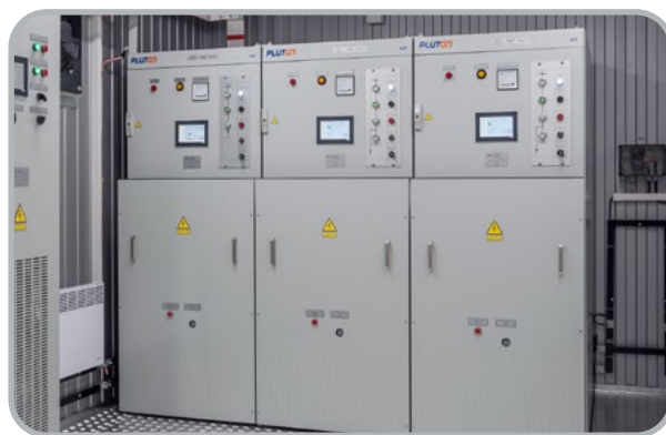
DC SWITCHGEAR
