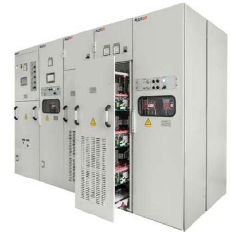
Выкатной выпрямитель в DC-щите (подстанция Sickla)
