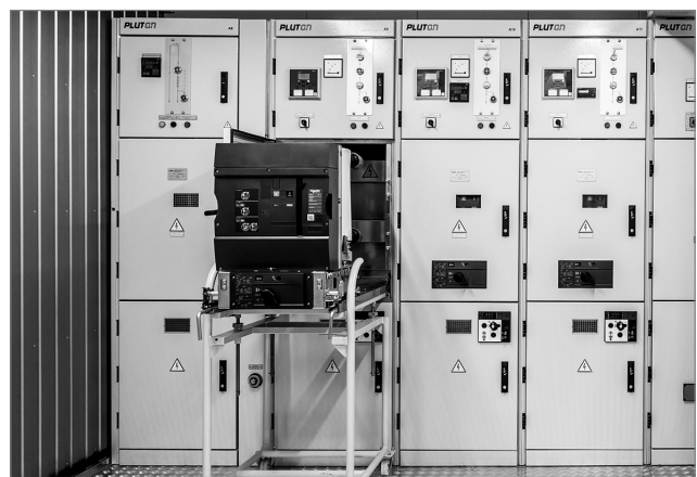
Розподільний пристрій 6 (10) kV середньої напруги
